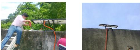
Figura 2 Instalación de los MFV con su respectivo ángulo de inclinación.
