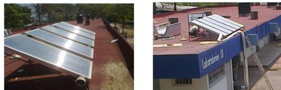
Figura 1 Banco de colectores solares planos y deshidratador de frutas
