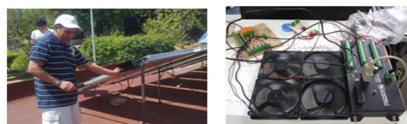
Figura 2 Entrada del aire a los colectores y ventiladores internos.
