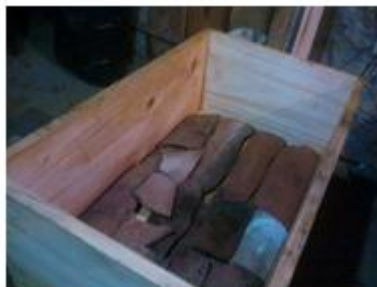
Inicio de colocación del aislamiento.
