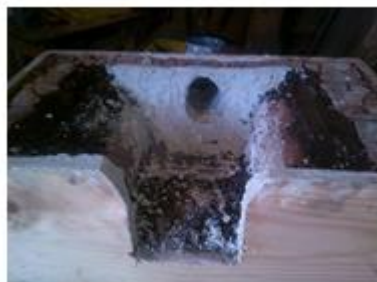
Terminación de colocación del aislante.
