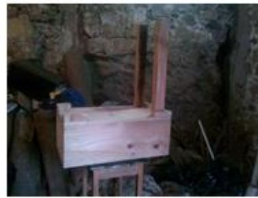
Colocación de la base.
