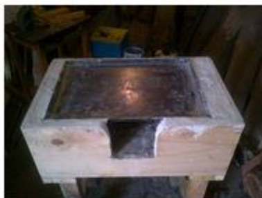
Colocación y sellado del comal.
