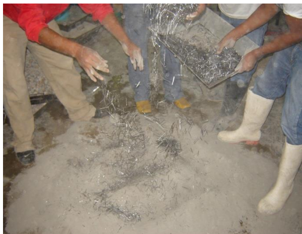
Figura 2 Dosificación del concreto con fibras metálicas
