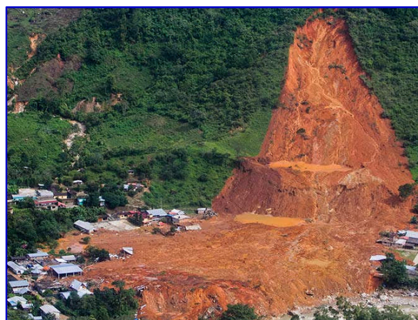
Figura 2. Deslizamiento ocurrido el 15 de septiembre de 2013 en la comunidad la Pintada, municipio de Atoyac de Álvarez, Gro.
